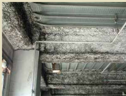
鉄骨耐火被覆
